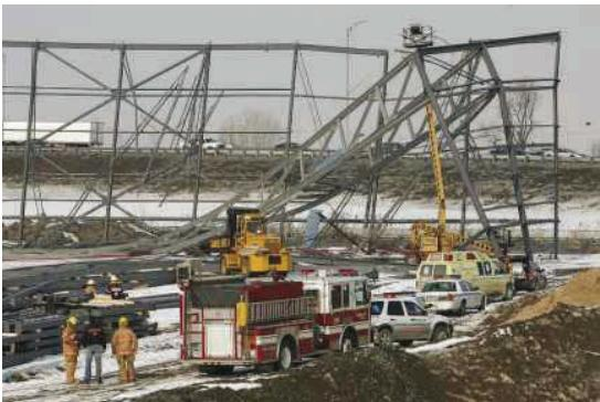
L'incident est survenu quand un des murs sur lesquels on tentait de poser les poutres du toit a bougé. Ce mur était soutenu temporairement par des poutres et l'une d'elles avait glissé sur le sol gelé. De plus, la CSST note que les poutres du toit qu'on était en train d'installer n'étaient pas suffisamment soutenues.
